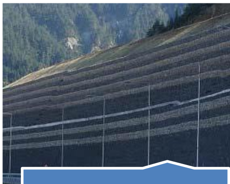
Τοίχοι αντιστήριξης από συρματοκιβώτια
