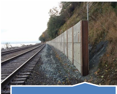
Τοίχοι αντιστήριξης από οπλισμένο σκυρόδεμα
