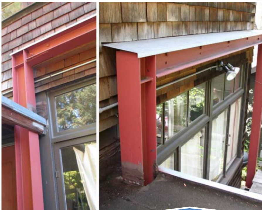
Δομική ενίσχυση κτιρίων
